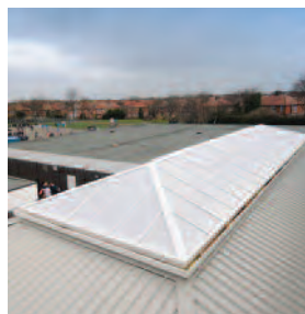
Lanterneaux, éclairage de toiture et ouvrants de désenfumage individuels
